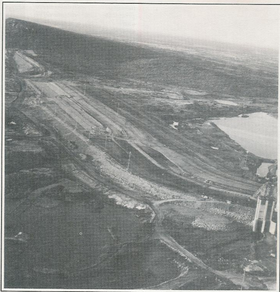
Diga di Corumana - MOZAMBICO
